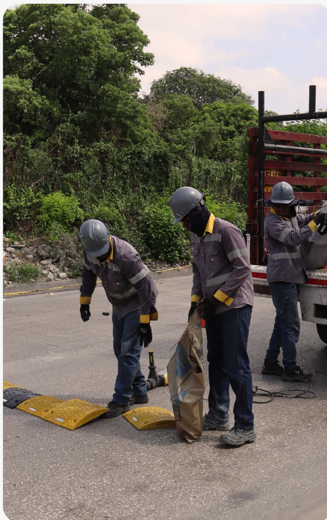
Instalación de reductores por parte de funcionarios de amoblamiento urbano municipio de Soledad, Atlántico.
